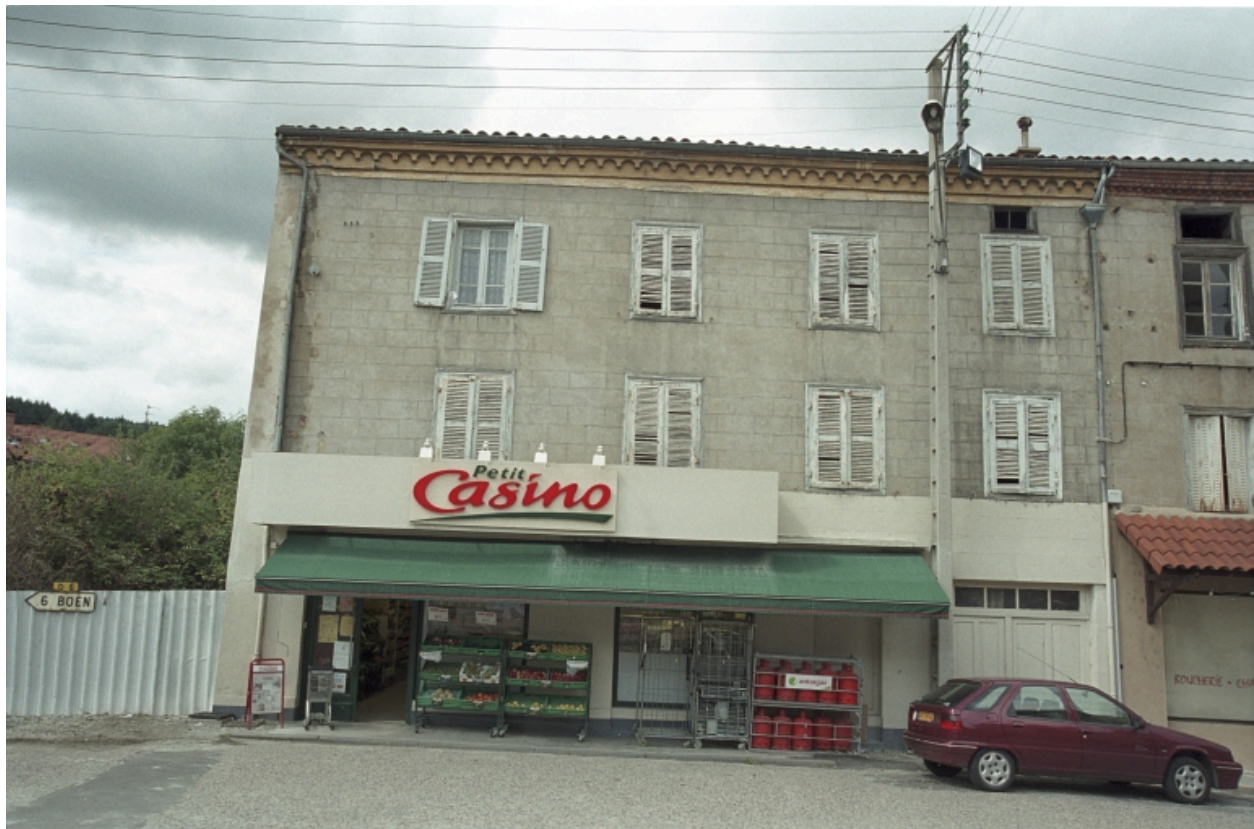
Vue d'ensemble de la façade principale sur la place de l'église.
