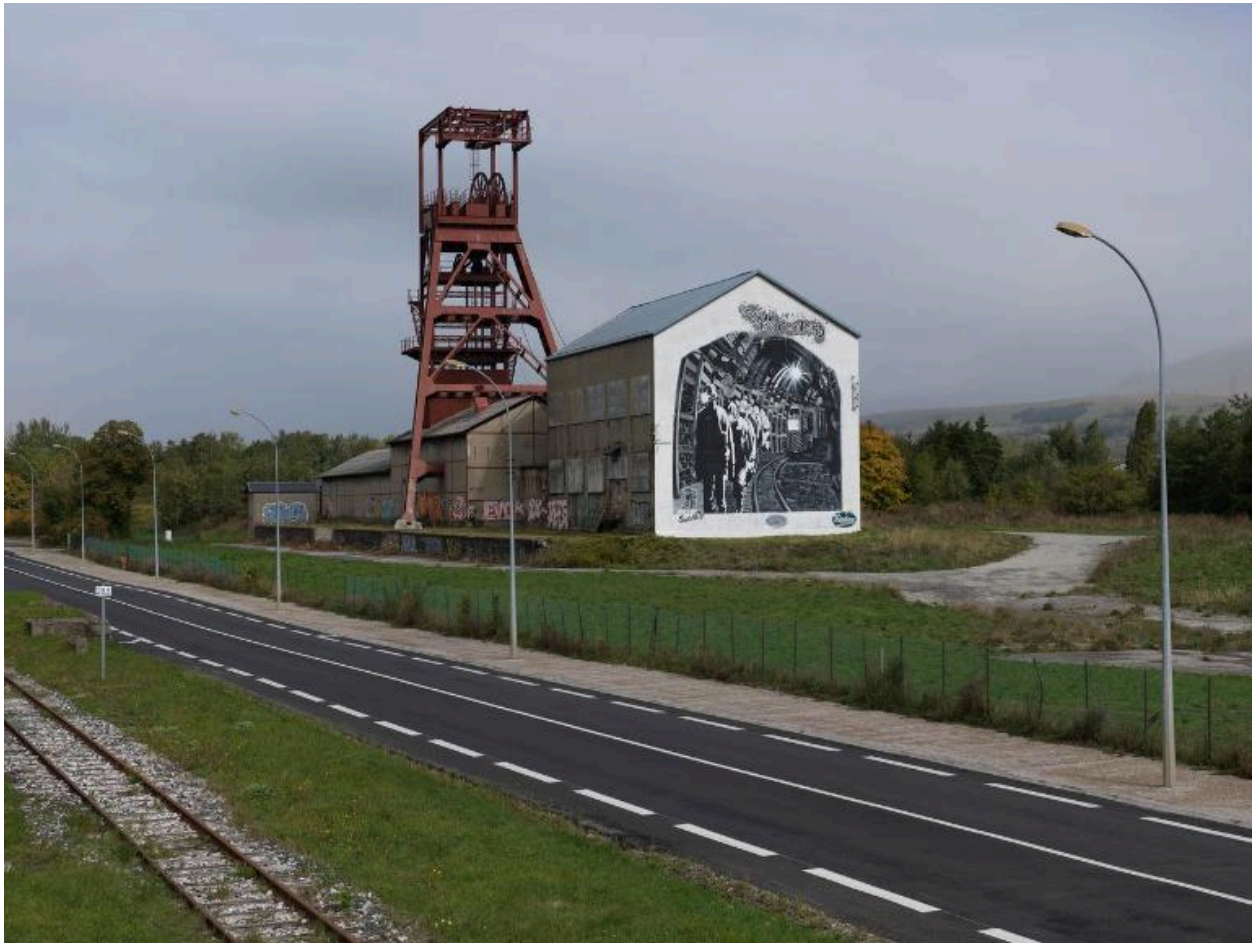
Vue d'ensemble du chevalement métallique
