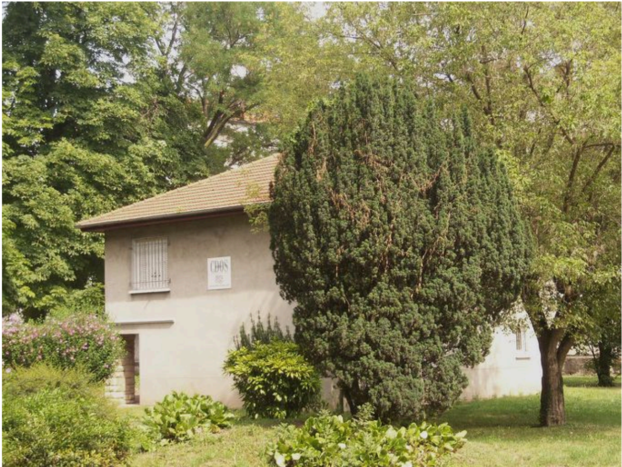
Bâtiment Nord Est, élévation Sud
