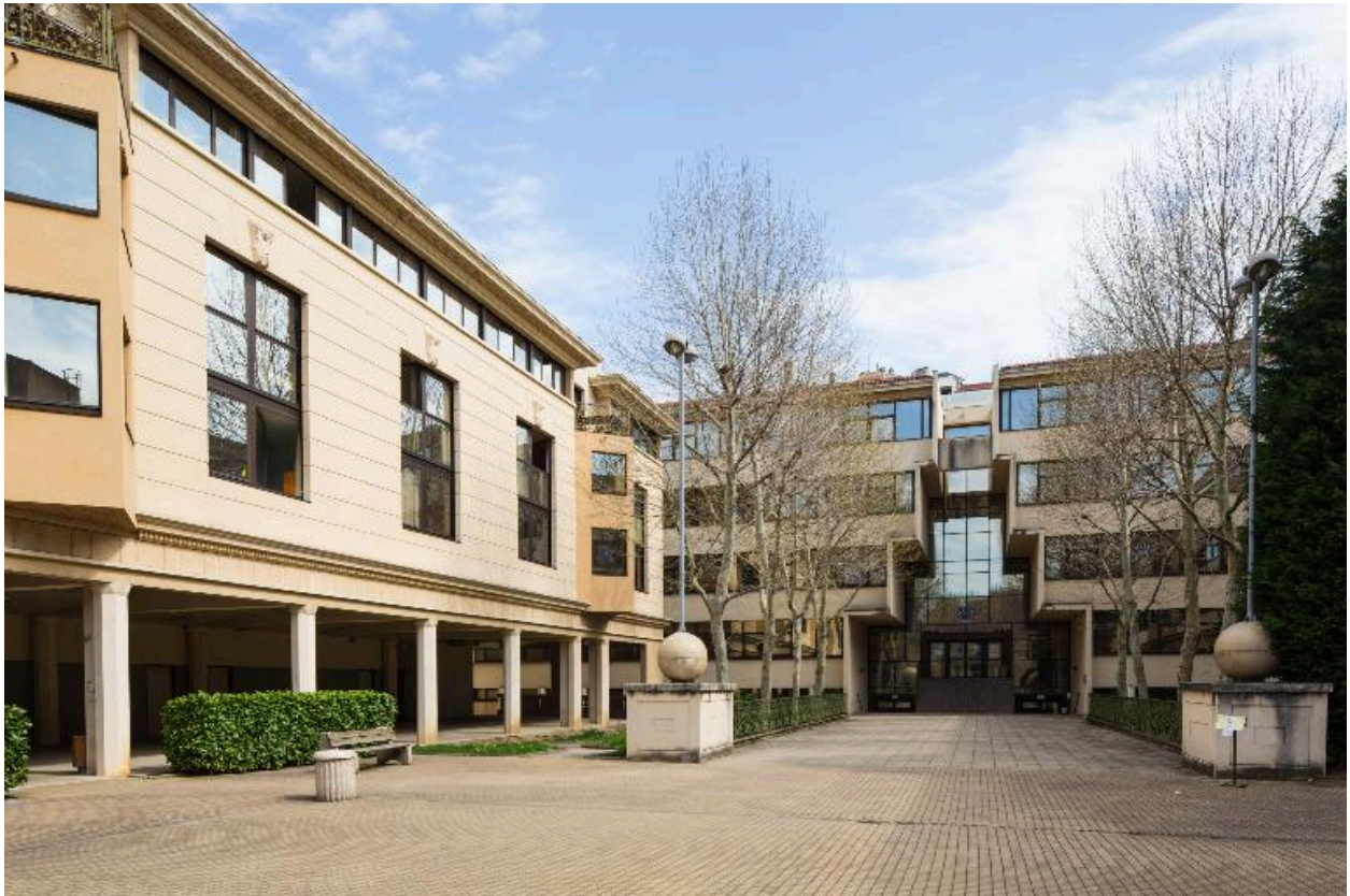
Vue de la façade sur cour
