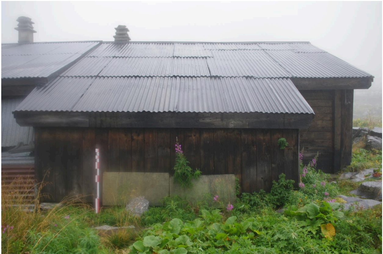
Vue de la façade postérieure ouest
