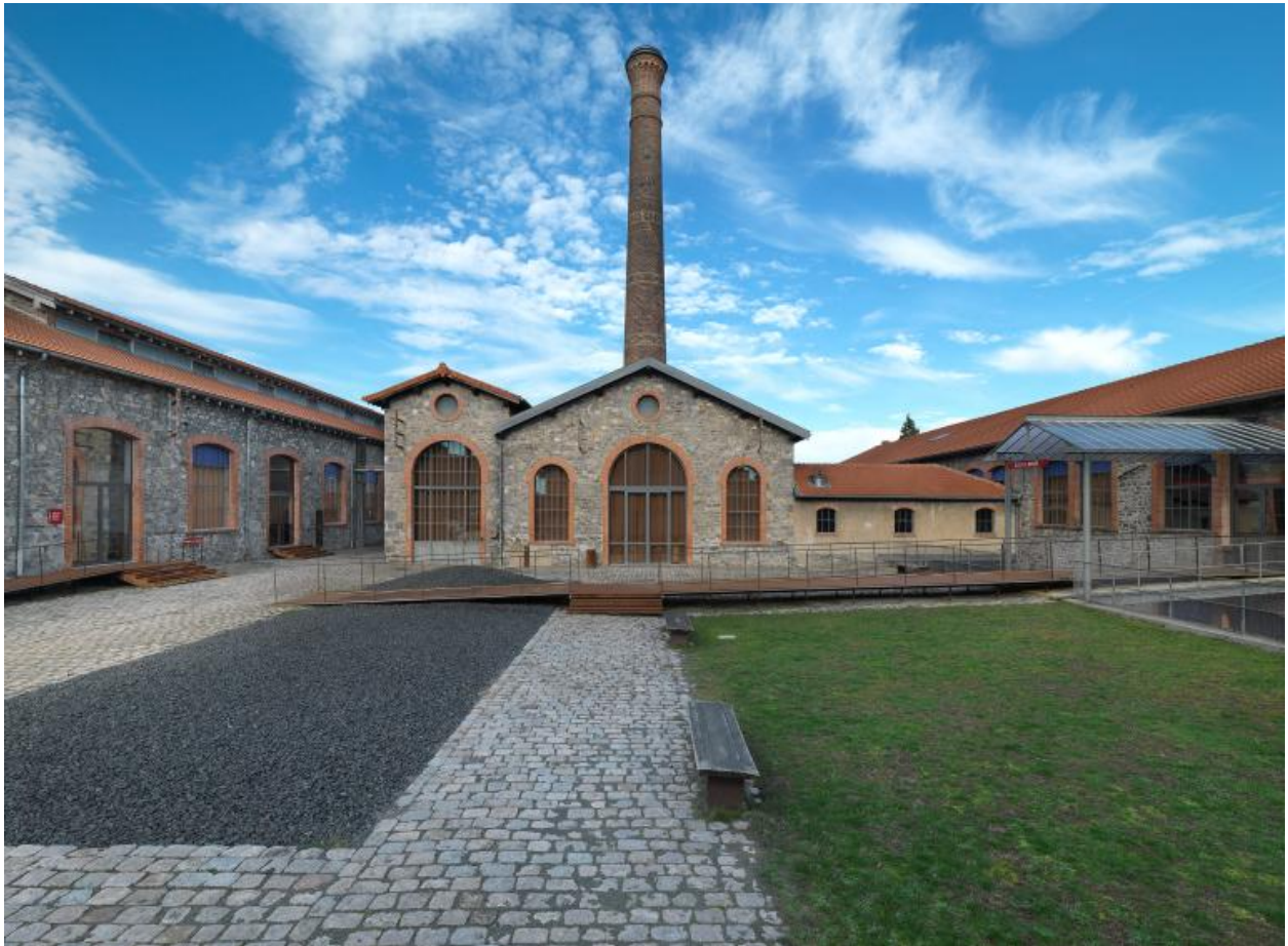
Vue du bâtiment des machines.
