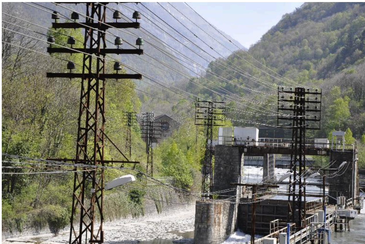
Vue du canal de Rioupéroux
