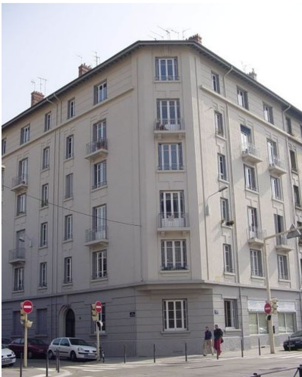
Vue générale de l'élévation
