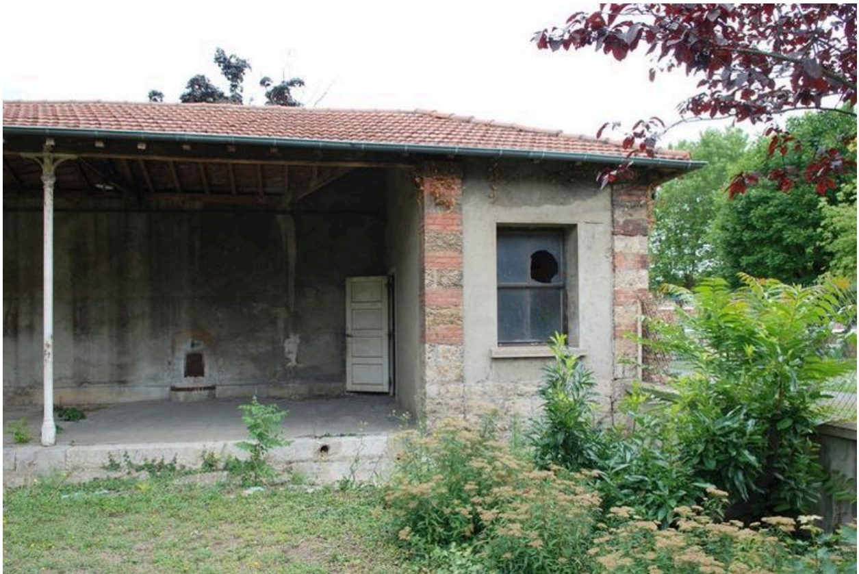
Promenoir, partie sud-est : sanitaires à leur emplacement d'origine
