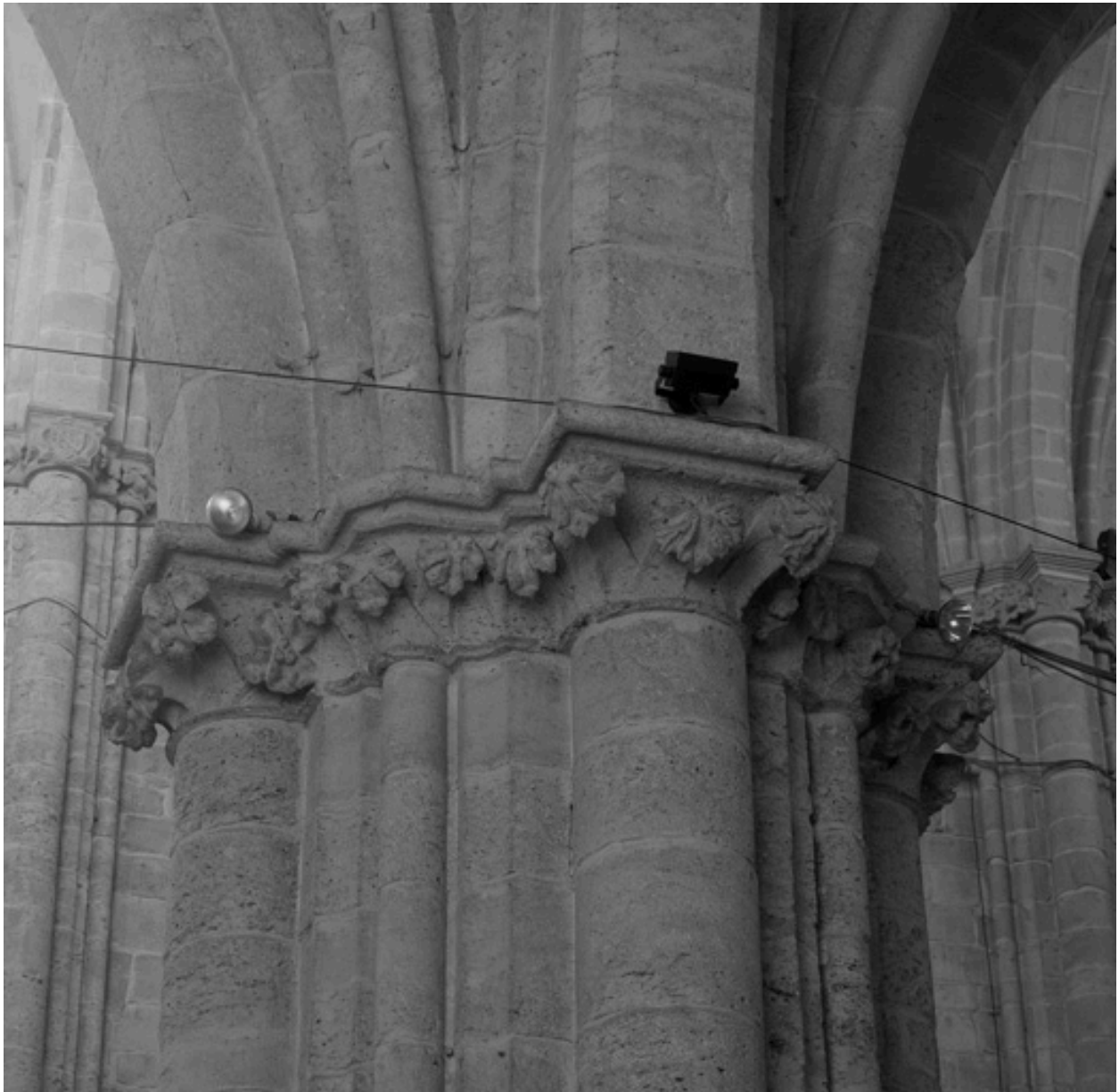
Détail de chapiteaux : support entre les travées III et IV, bas-côté nord (?).
