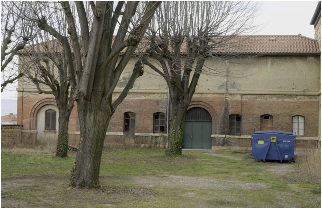
Gymnase, élévation antérieure
