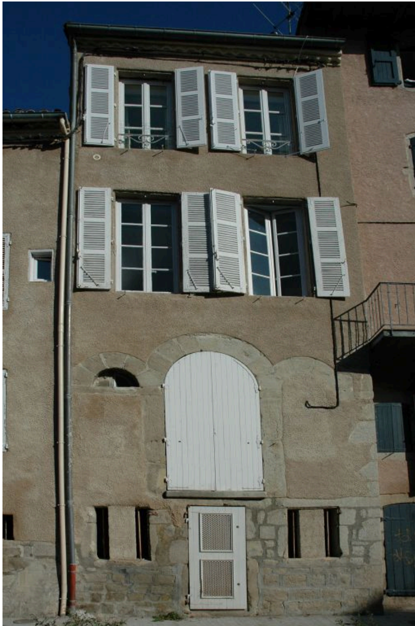
Elévation postérieure sur le quai du Vizézy.
