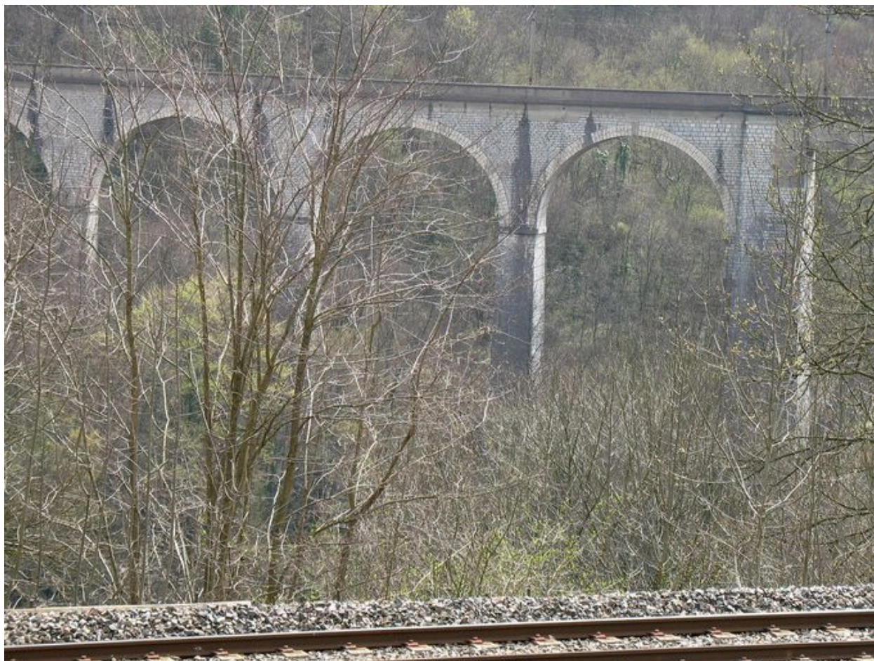
Arches de la rive gauche, face amont : vue partielle
