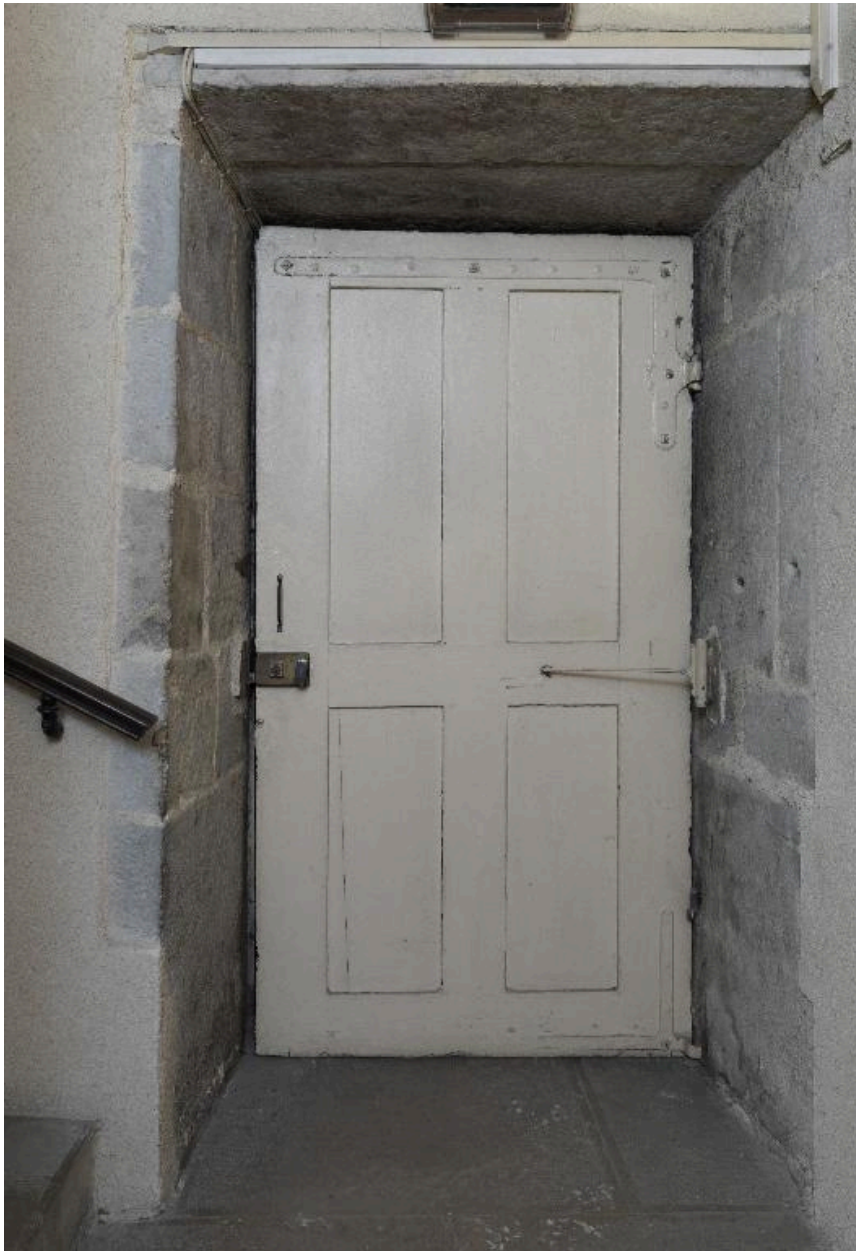
Escalier A, porte donnant sur le vestibule du lycée
