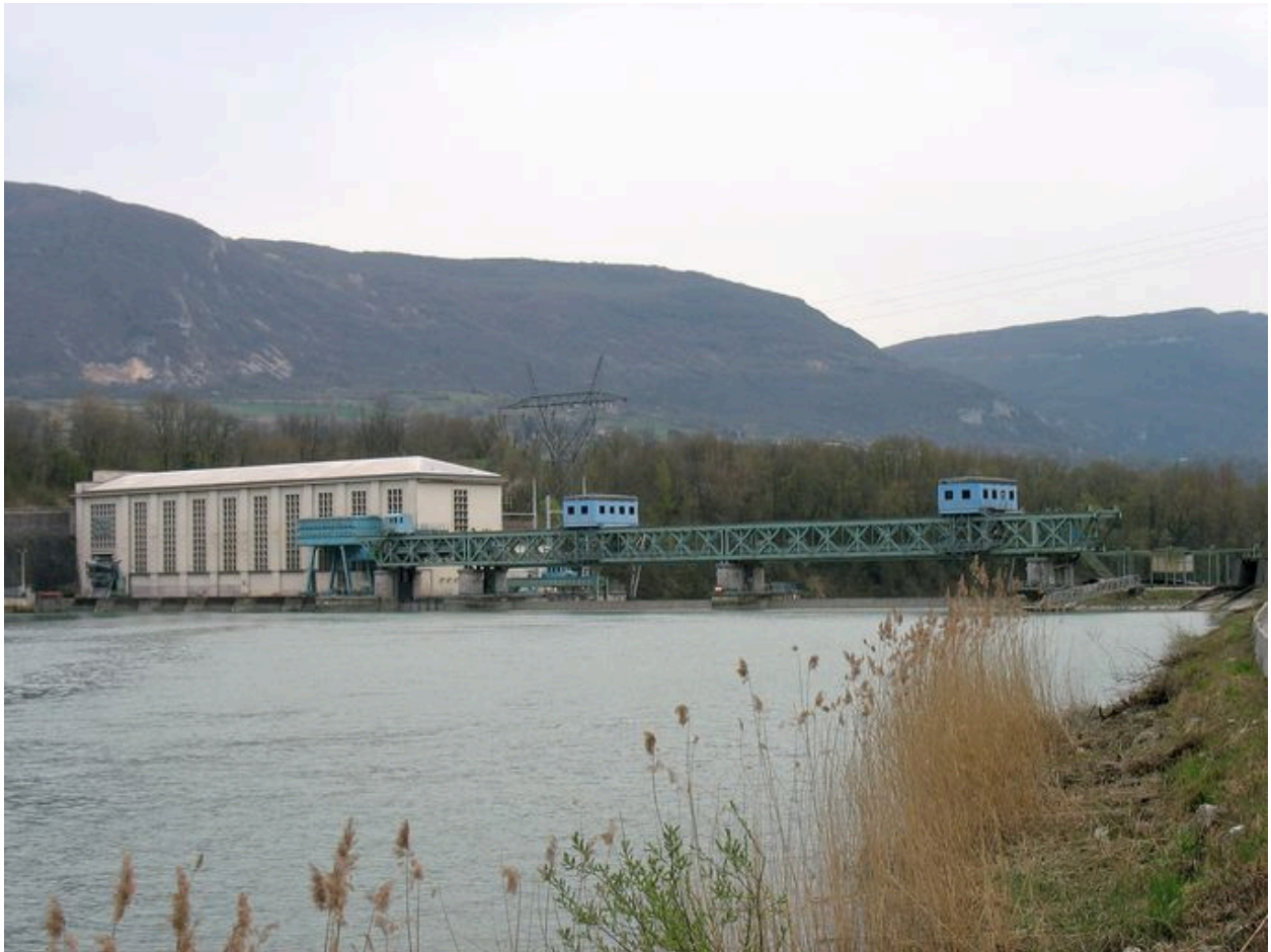
Vue de l'usine-barrage dans le site, face amont (nord), depuis la rive droite
