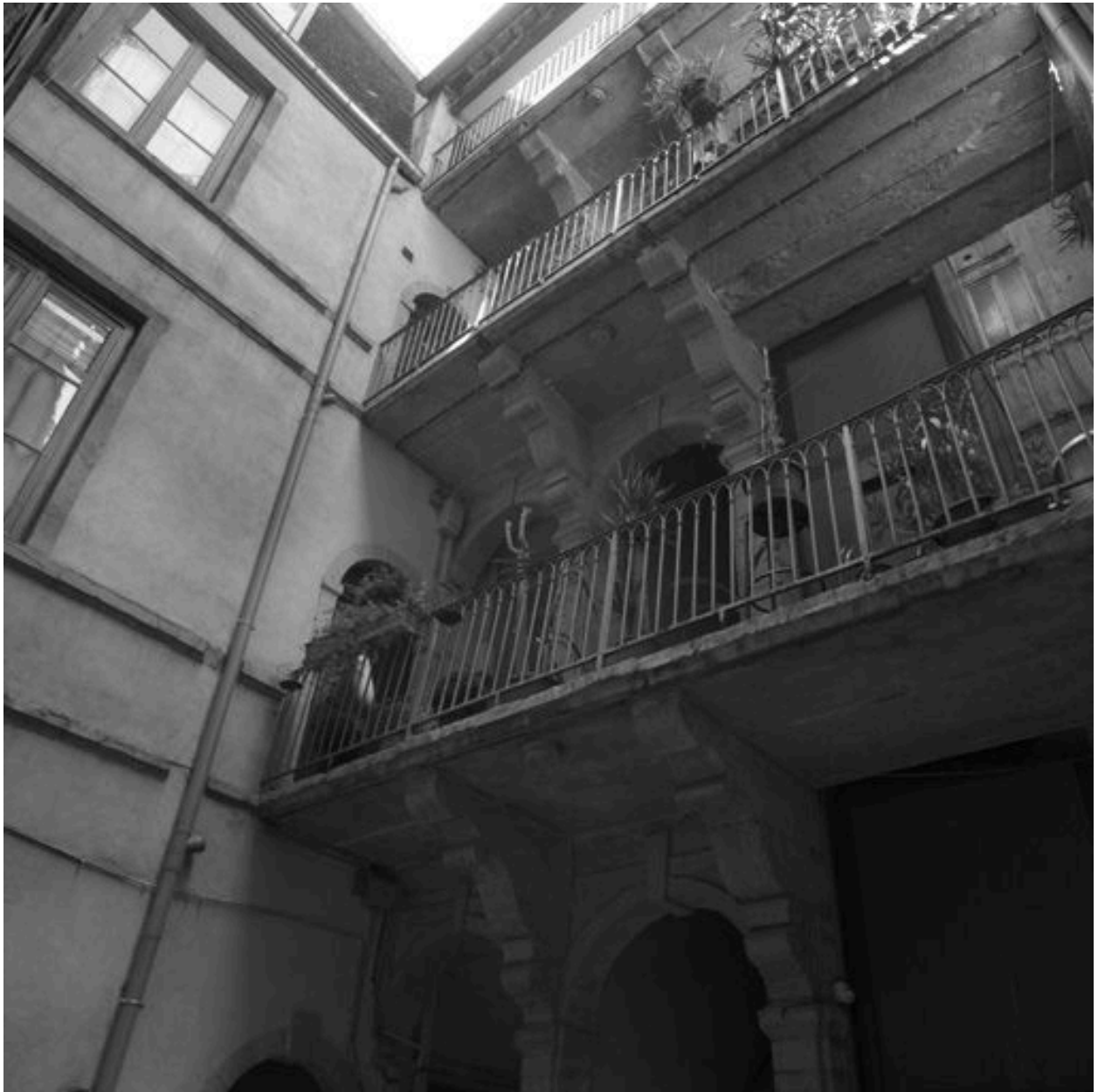
Cour, coursières et escalier vus depuis le 1er étage
