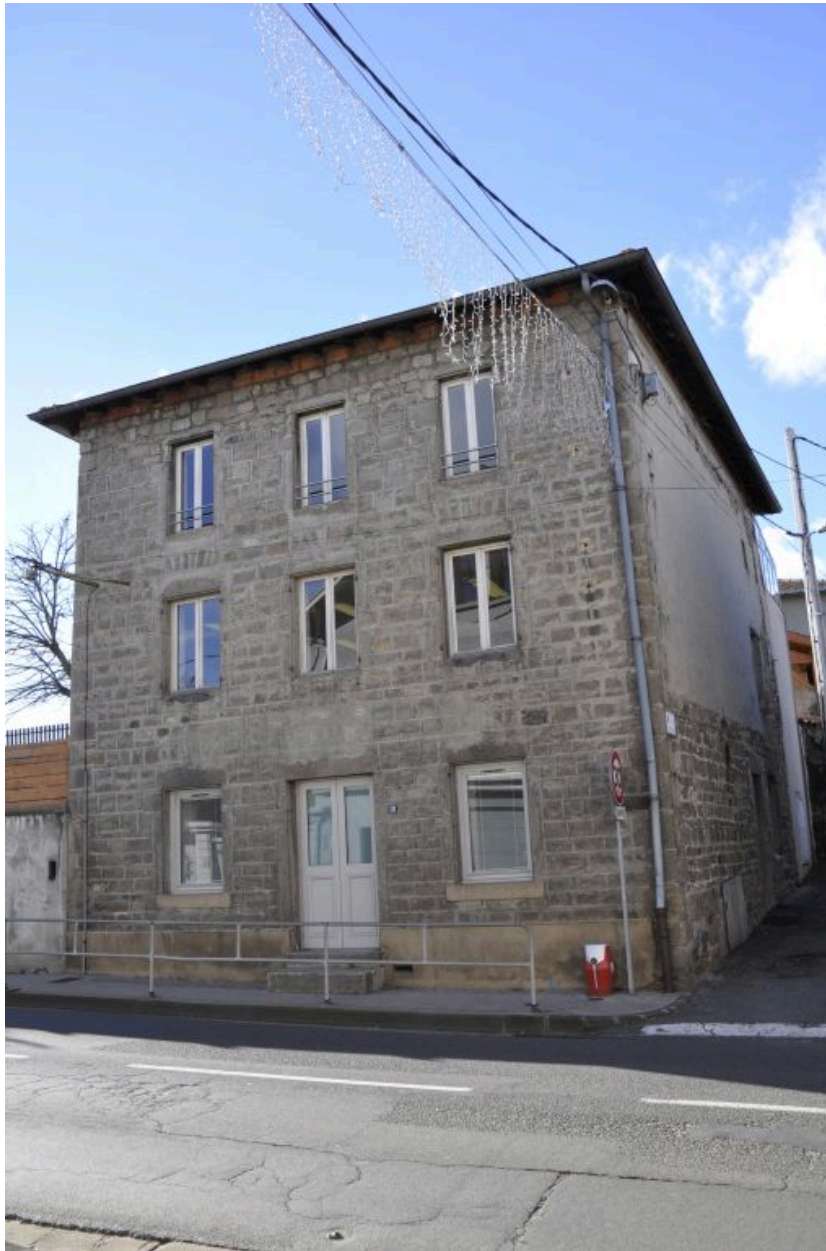
1986 AE 40. 18 avenue Thermale. Maison, vue d'ensemble.
