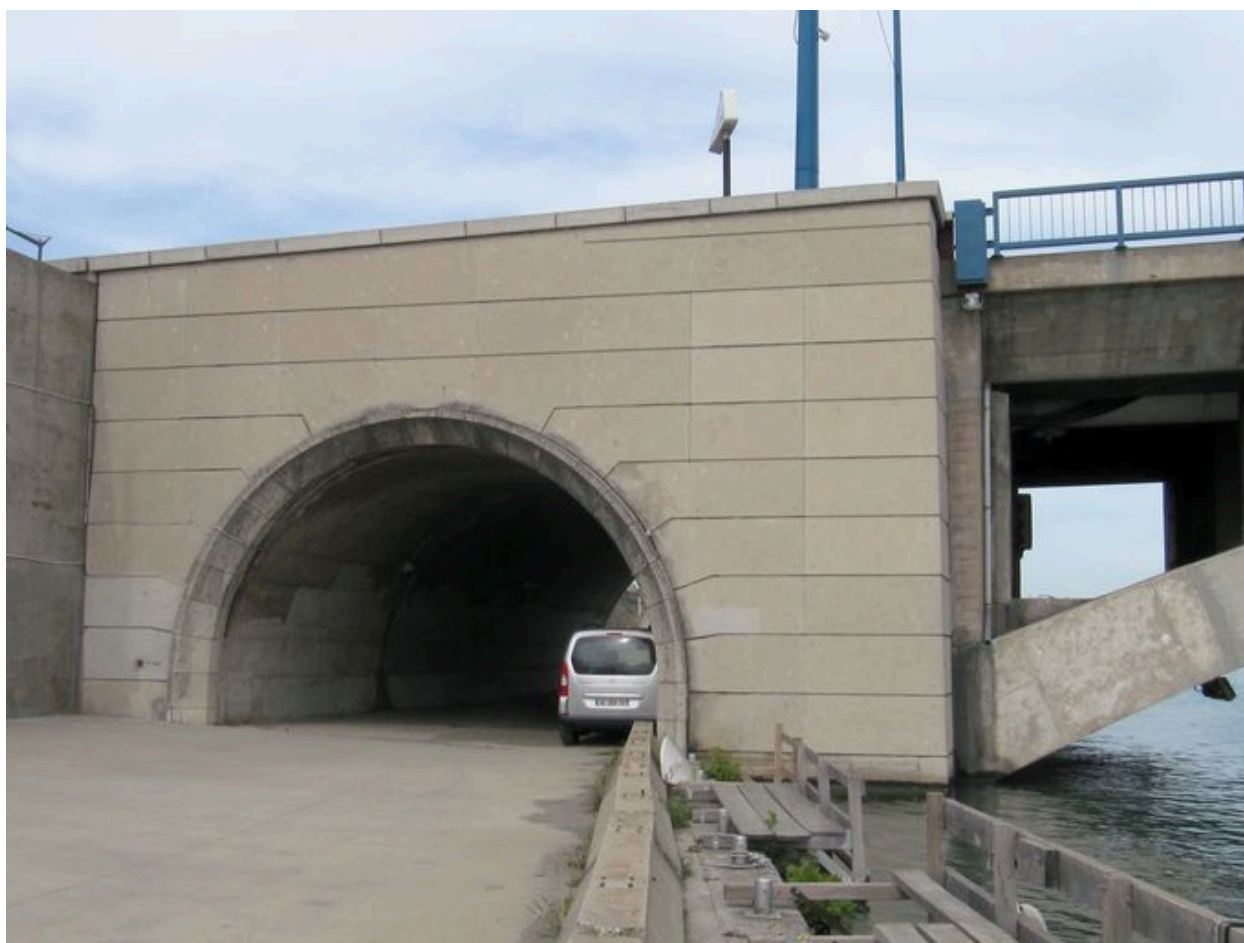
Culée passante droite, face aval, vue générale (depuis la rive droite)
