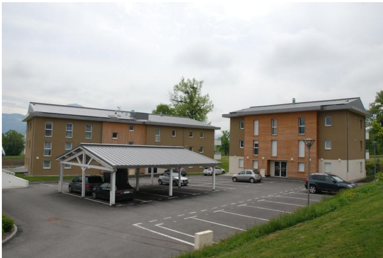
Vue du nouveau quartier sud-est (2016 A7 1596, 1598, 1599, 1601).
