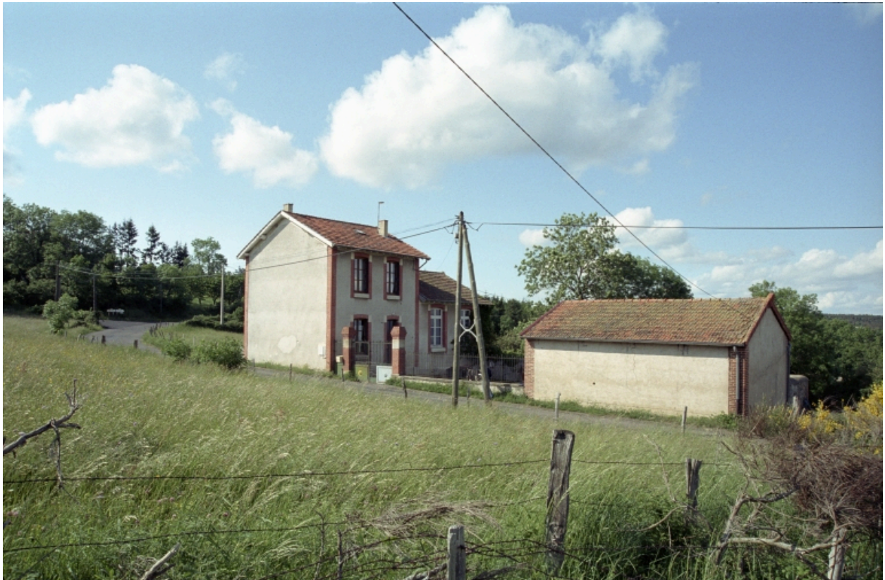
Ecole du hameau de Say, vue générale depuis le sud.
