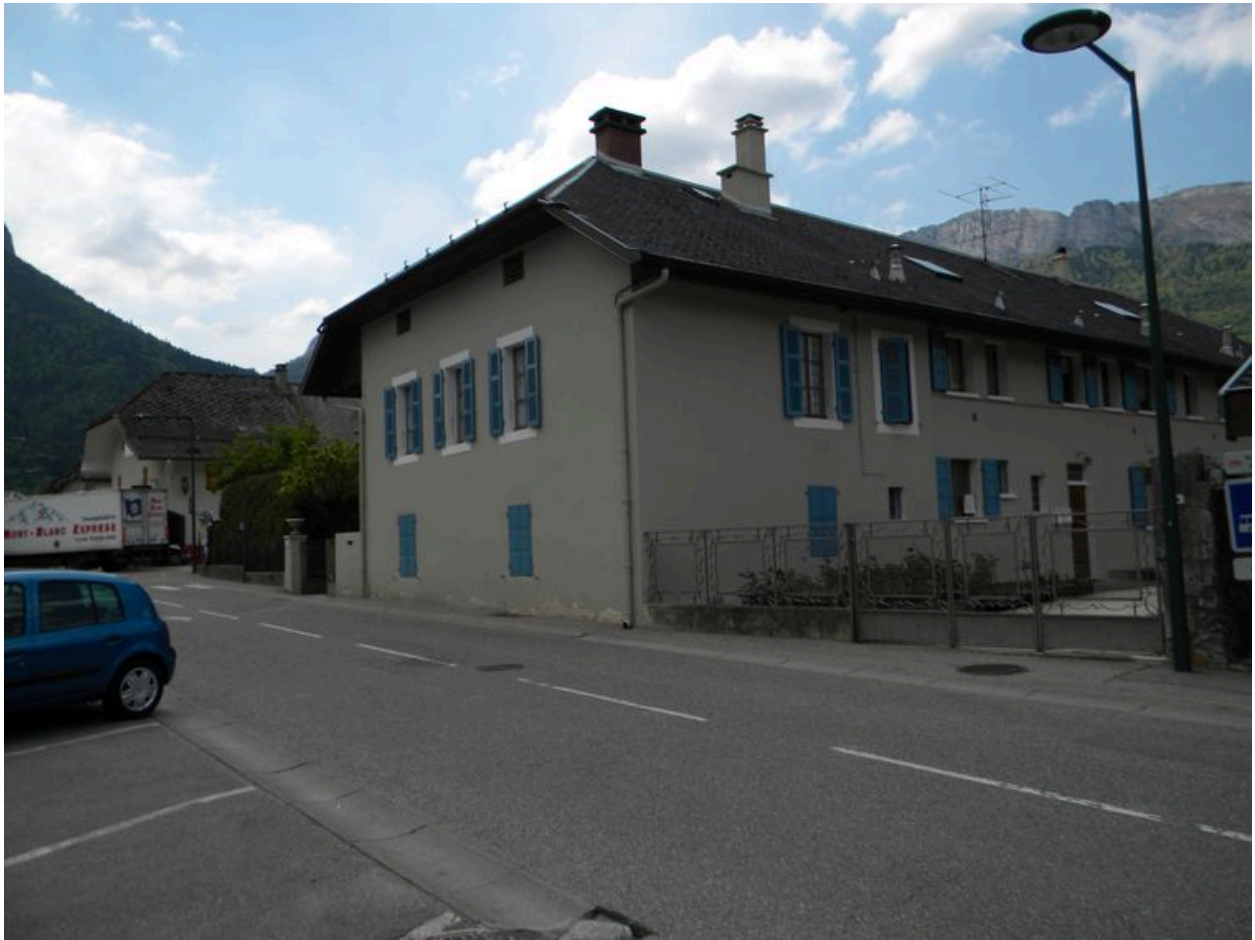
Façade nord d'une ferme très transformée près de la mairie (C5 740).
