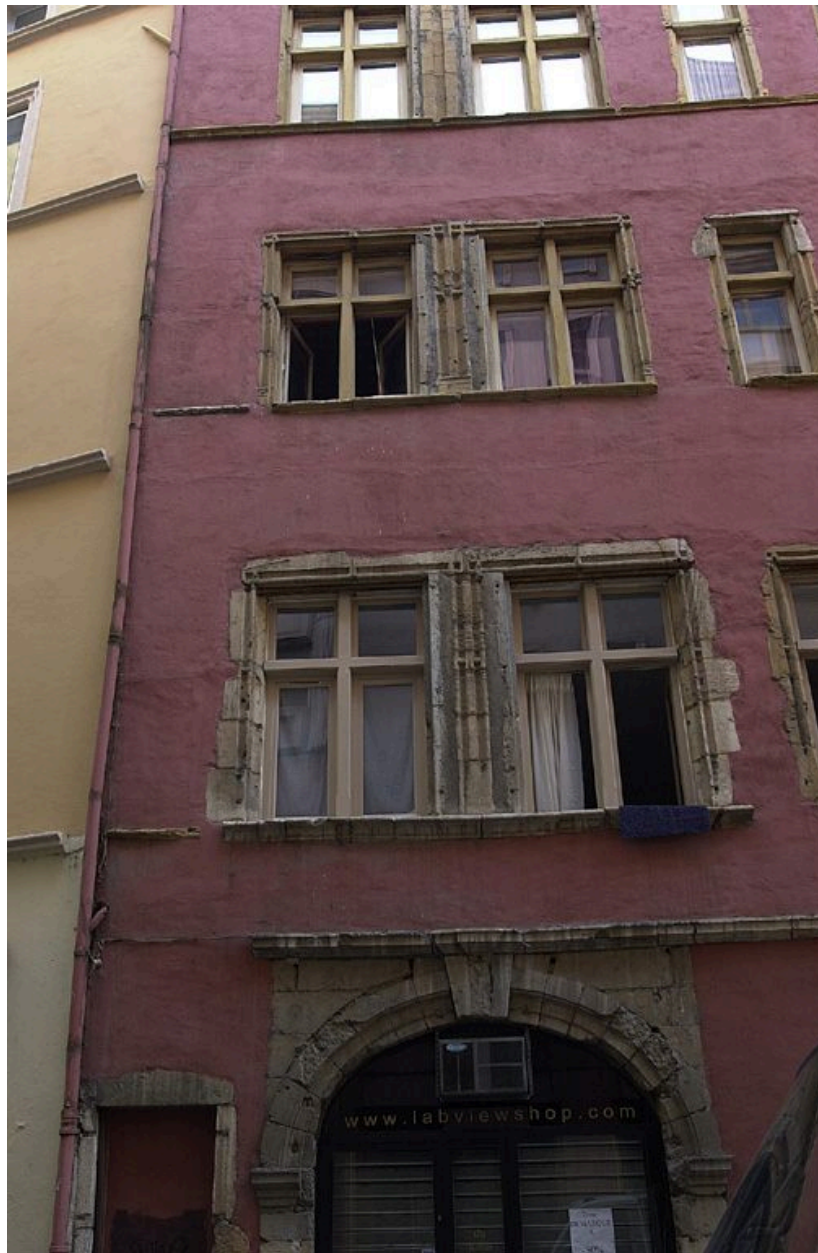
Elévation antérieure : détail de baies
