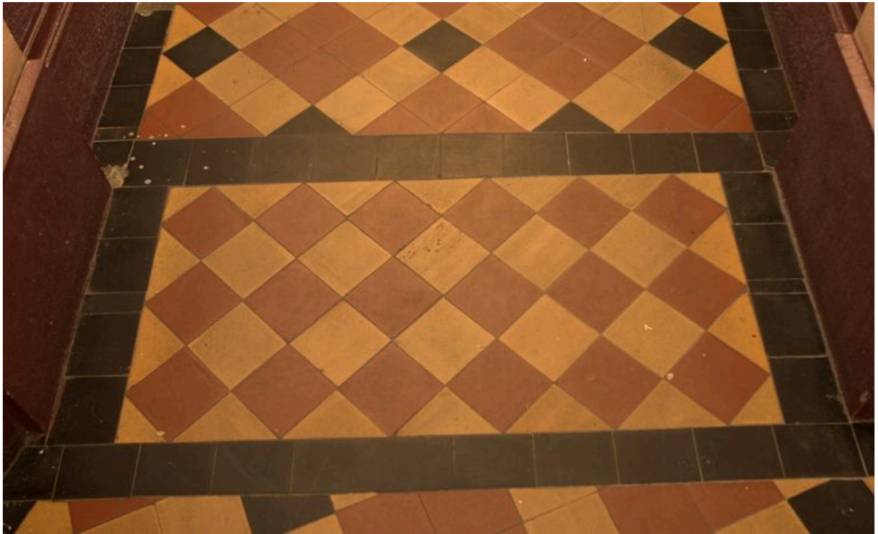
Détail du carrelage au sol dans le vestibule
