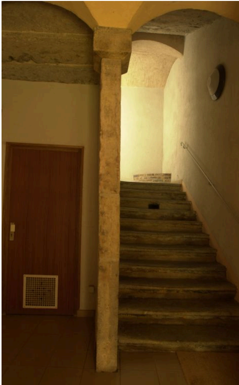
Départ de l'escalier : pilier à chapiteau cubique soutenant la voûte d'arêtes
