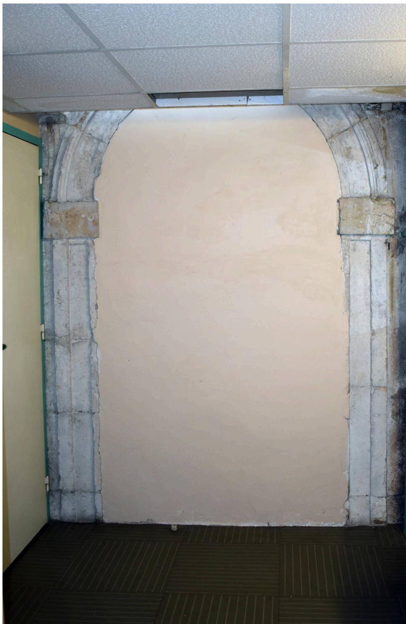
Bâtiment A (sanitaires jouxtant la salle des professeurs) : ancienne porte ouvrant sur l'église, aujourd'hui murée
