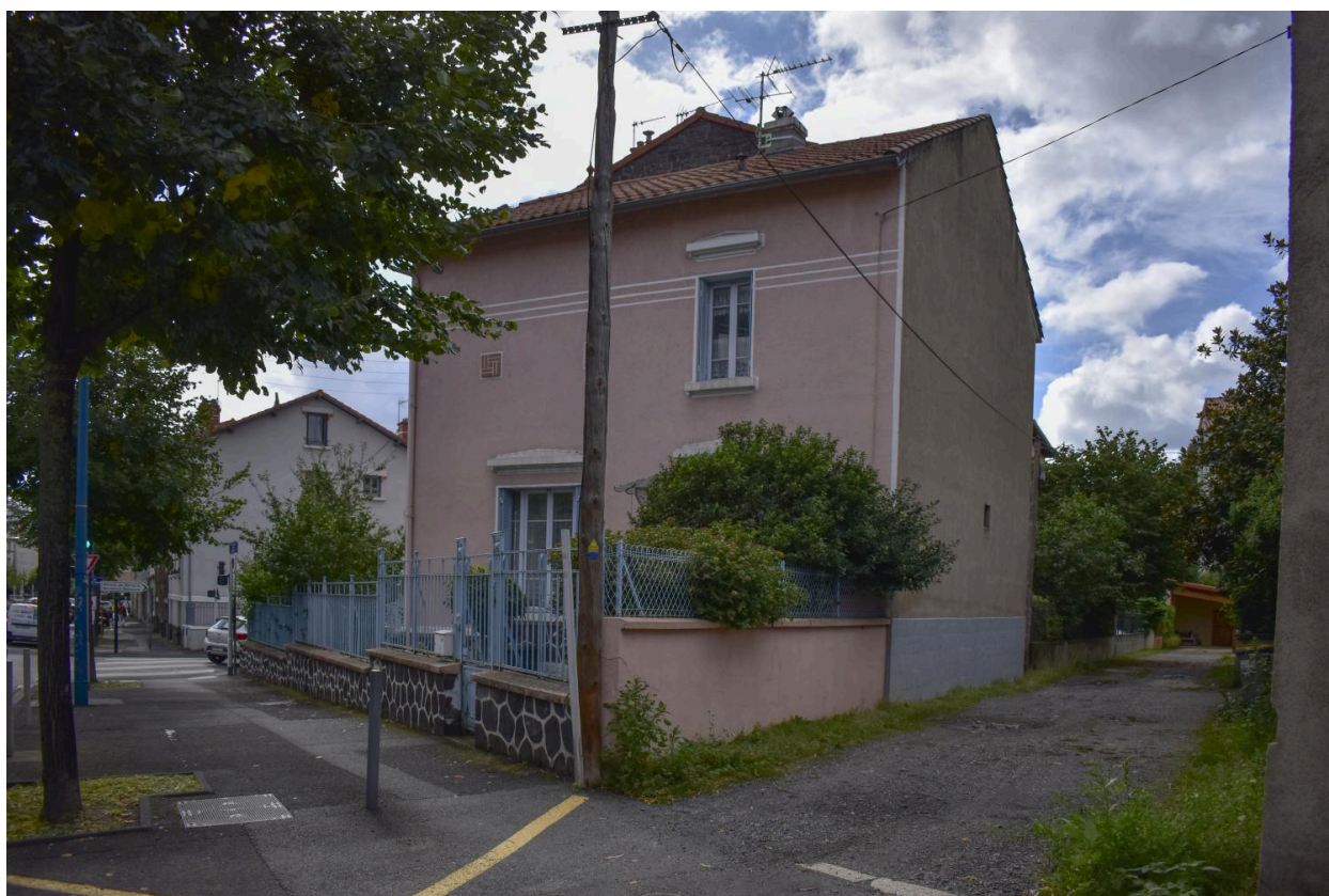
Maison à l'entrée de l'impasse desservant le lotissement Loradoux
