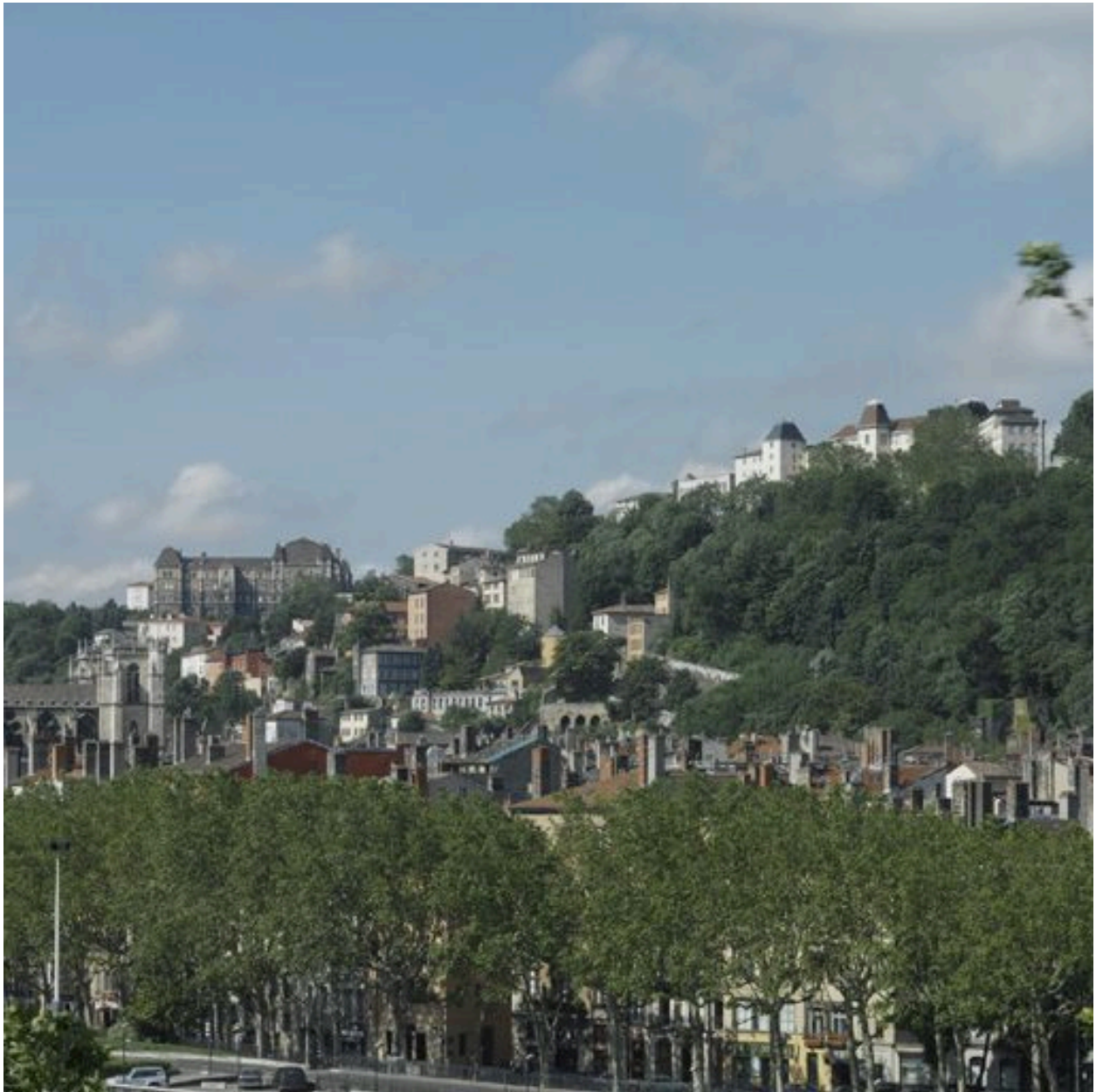
Le site vu depuis le quai de la Pêcheurie
