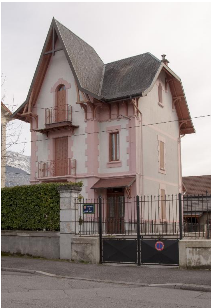
Façade nord et pignon ouest
