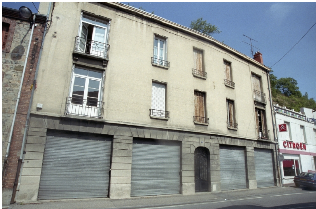
Boën, îlot 17, Lyon (rue de) 73. Vue générale de la façade sur rue.
