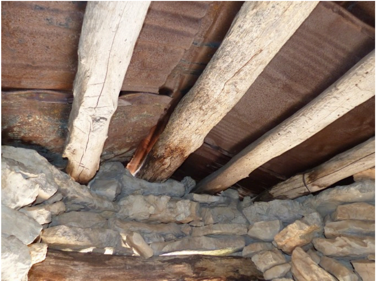
Charpente à pannes.
