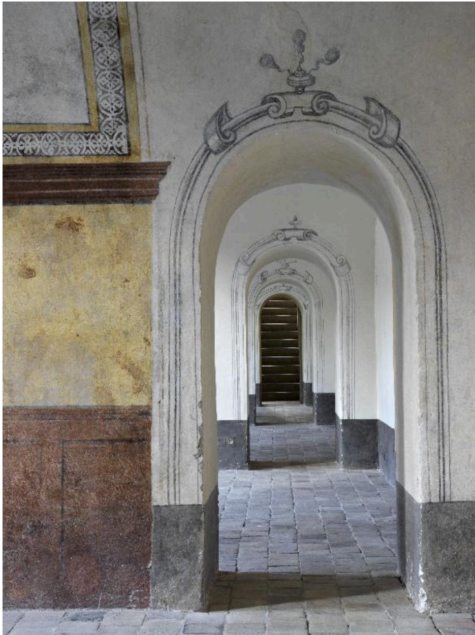
Tribunes nord, détail du décor des baies en enfilade
