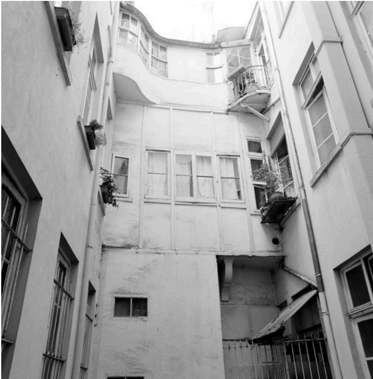
Cour, élévation des anciennes coursières
