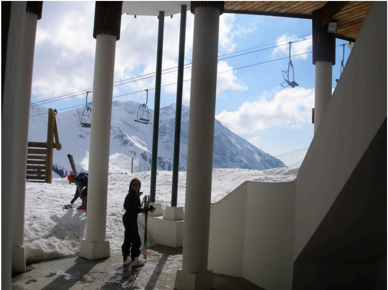
Vue de l'entrée aval
