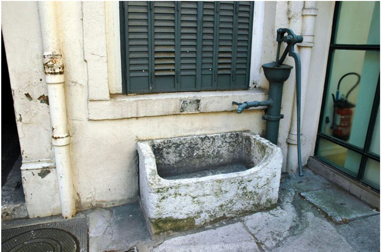
La cour, côté sud : pompe et bassin
