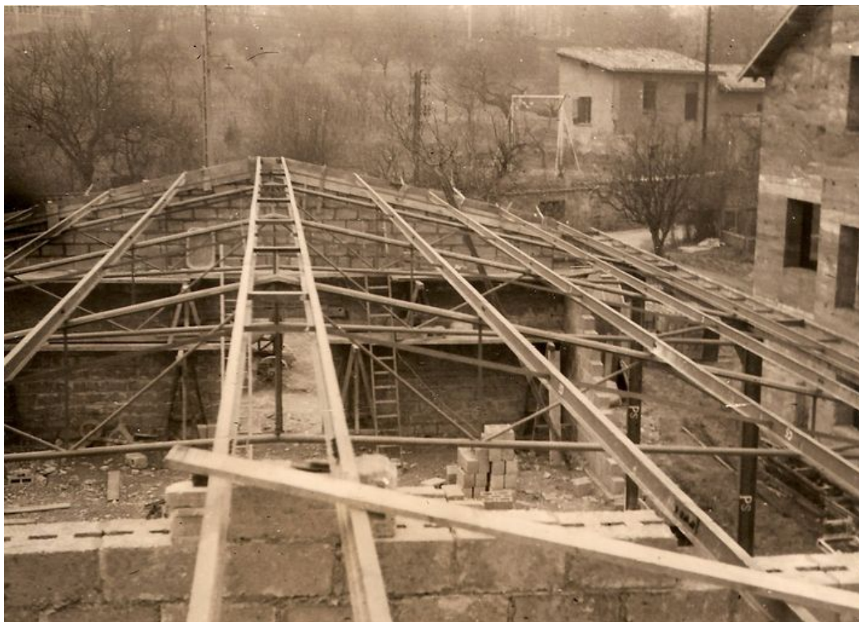
Construction de la chapelle des Trois Gouttes, rue Ernest Fabrègue, 1958
