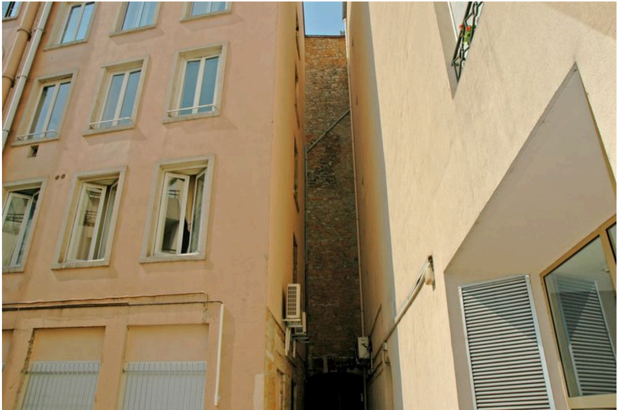
Vue du passage depuis le nord entre les élévations latérales des 95 et 97 Grande rue de la Guillotière
