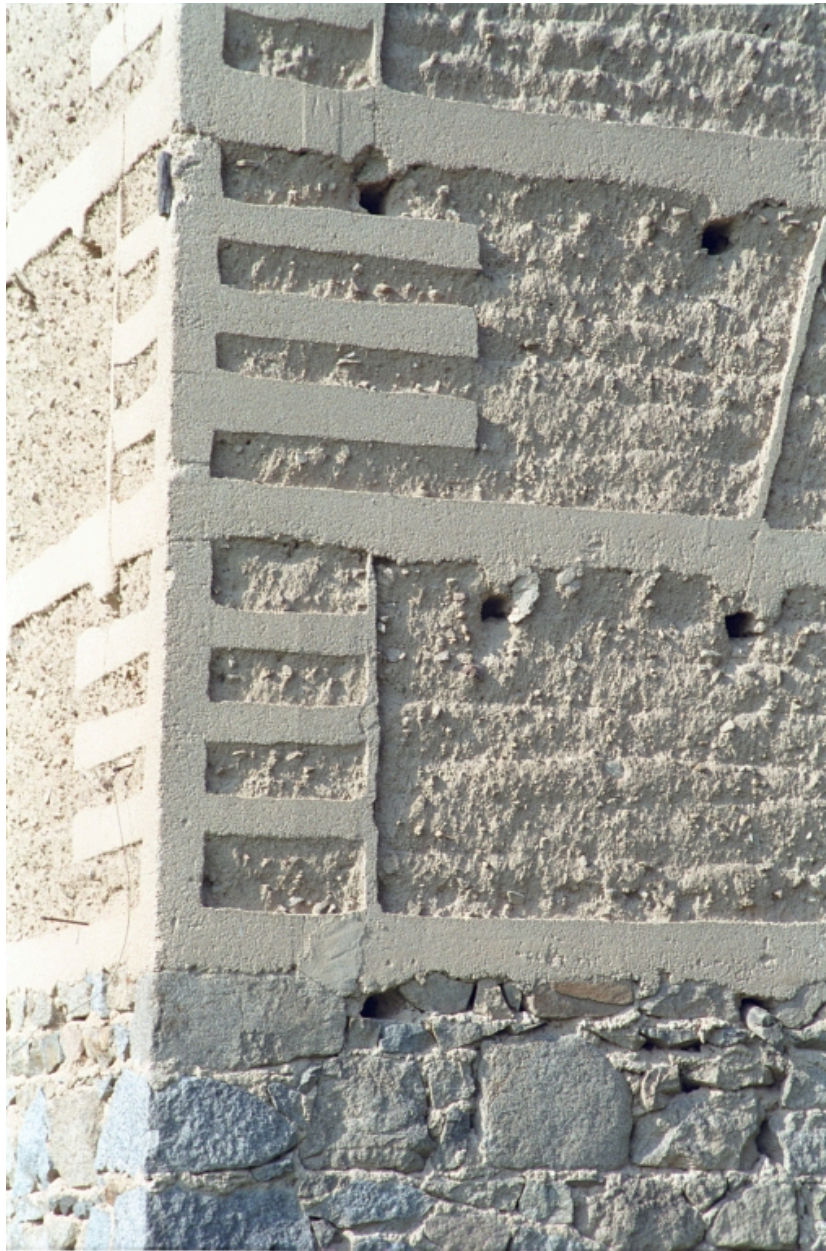
Cezay, le bourg, ferme : détail de pisé (limite 19e siècle 20e siècle).
