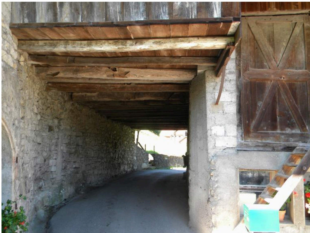
Détail de passage couvert sous l'accès au fenil.
