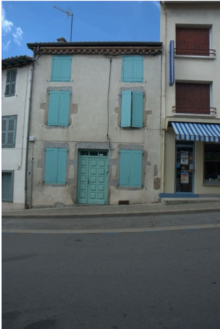
Îlot 6. Carnot (place) 09. Vue générale de la façade sur rue.
