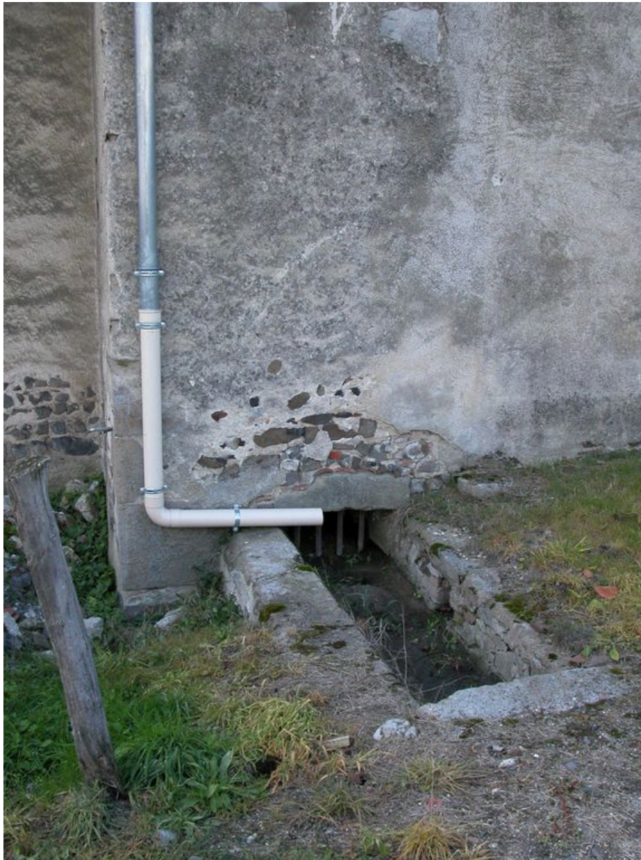
Détail d'une évacuation d'eau pluviale.
