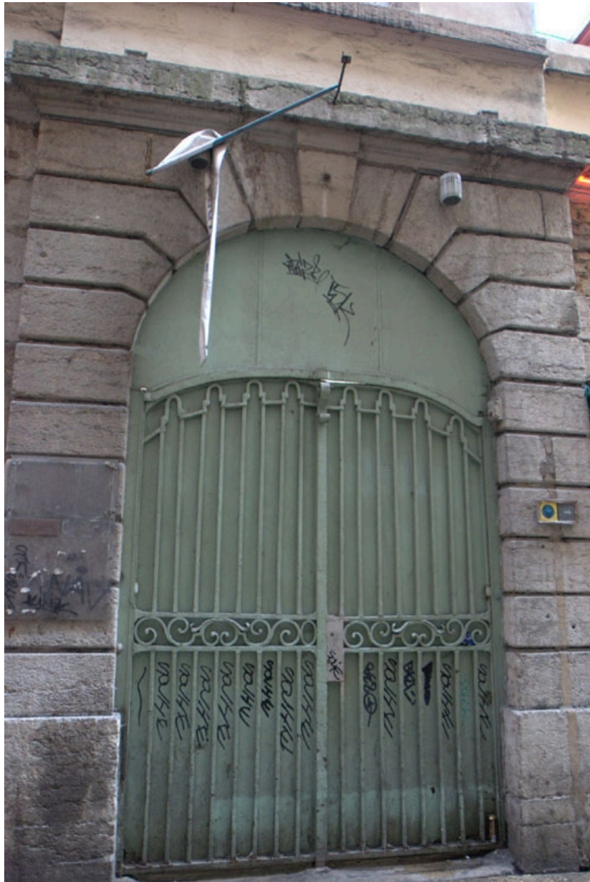
Accès latéral droit à la verrière
