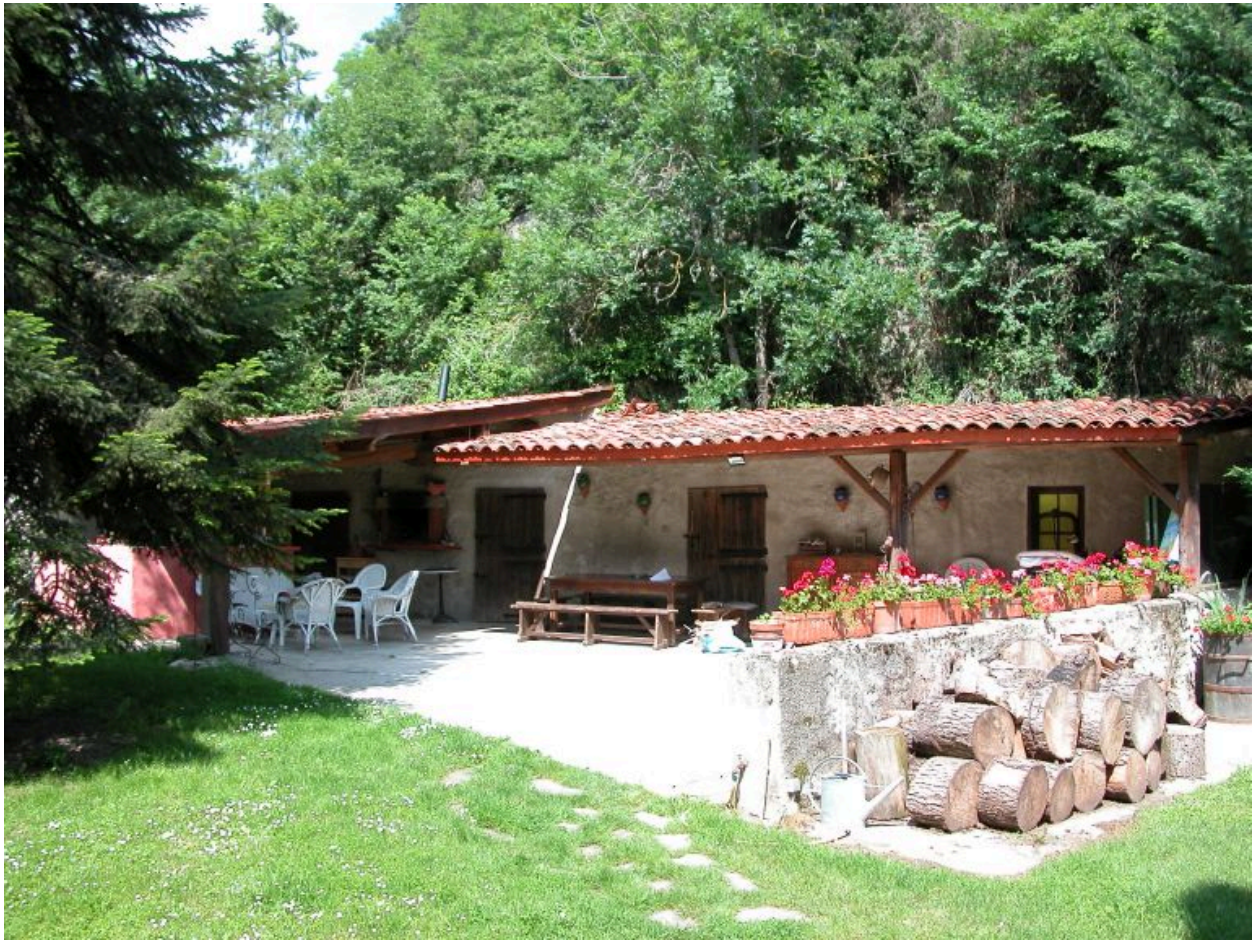
Vue d'ensemble de bâtiments annexes.
