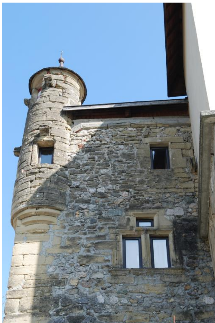
Partie haute de la façade sud de la maison forte.
