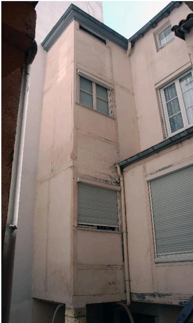
Elévation sur cour, avant-corps en encorbellement, structure bois
