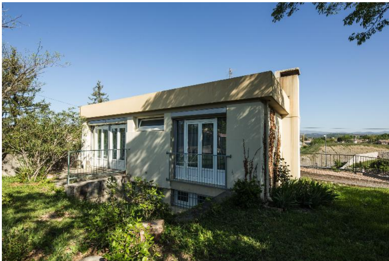
Maison de la directrice : vue extérieure, façade sud
