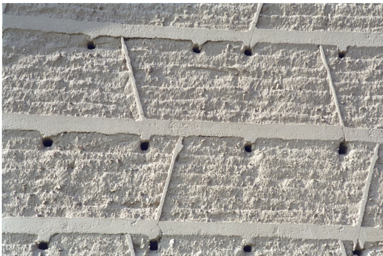
Cezay, le bourg, ferme : détail de pisé (limite 19e siècle 20e siècle).
