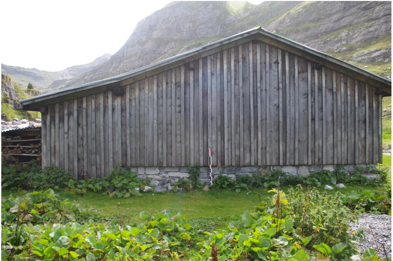
Vue du mur pignon nord
