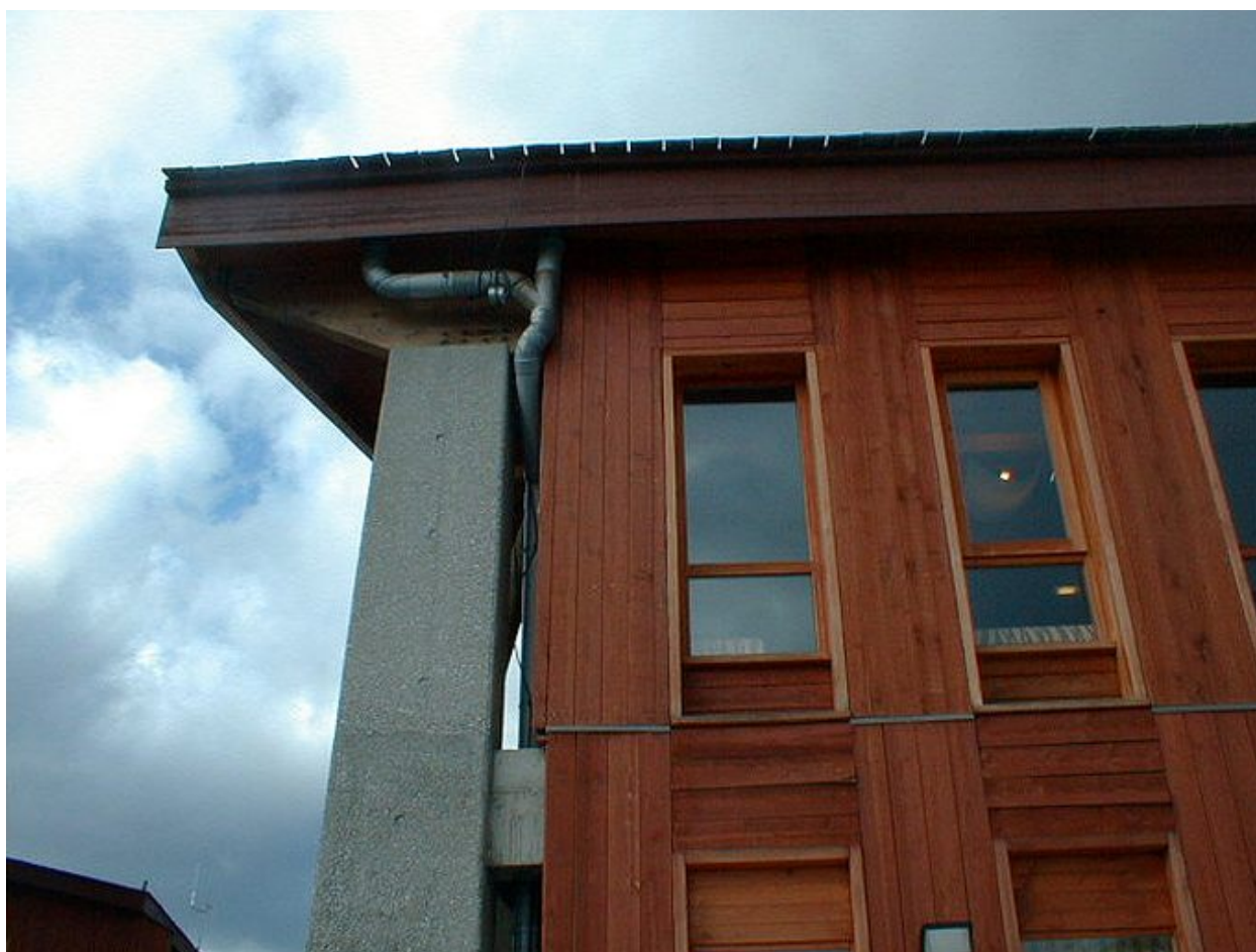
Façade sud-ouest. Détail
