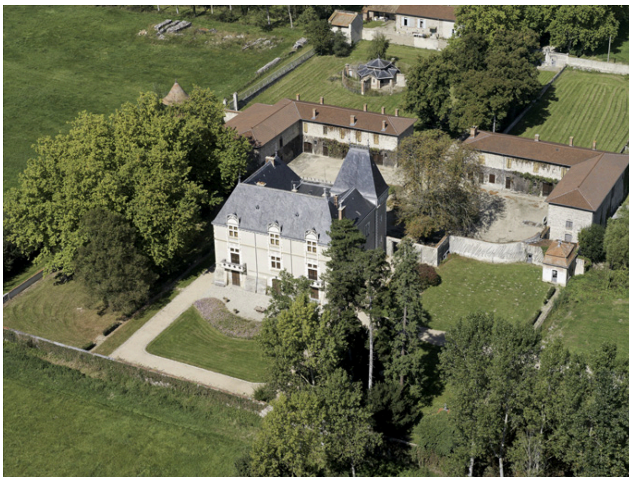
Vue d'ensemble aérienne depuis le sud-est.
