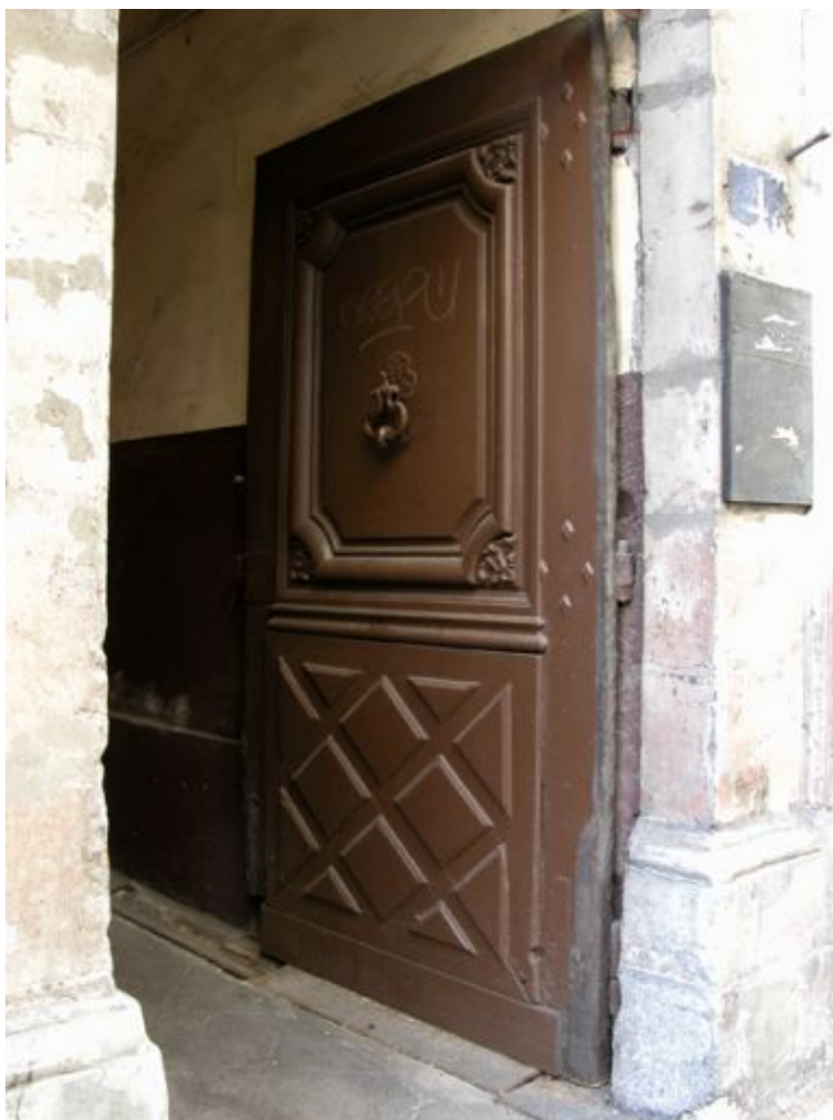
Façade rue Gentil, vantail de la porte
